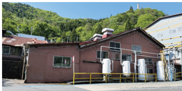
(中瀬製錬所 設備保全場)
