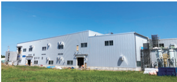
つくば工場増築棟の外観 2023年10月
