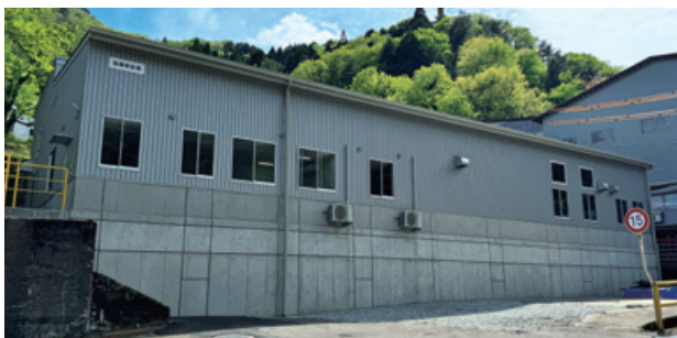
(新設された設備保全場建屋)
